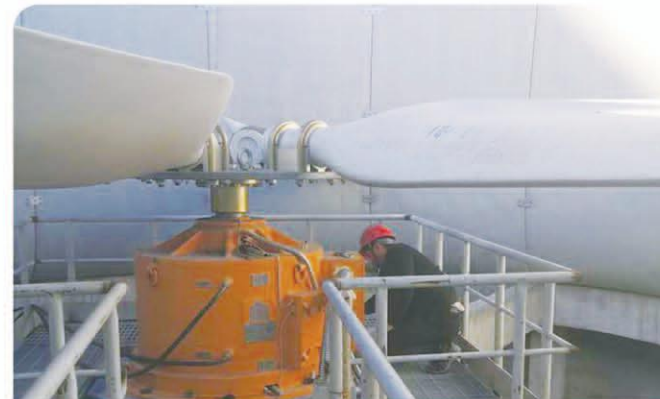
cooling tower fan
